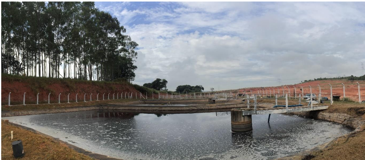
Figura 67: Lagoas de Armazenamento de Chorume
