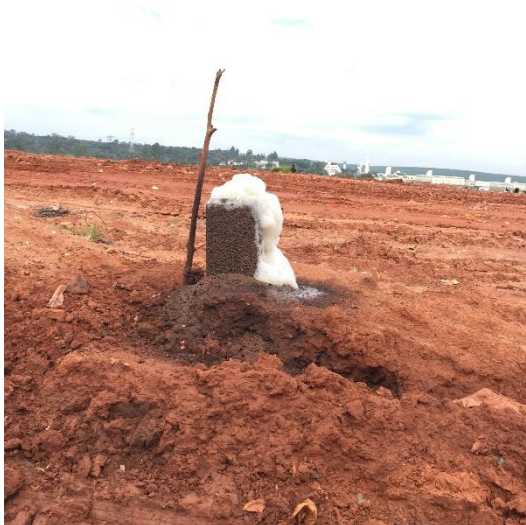
Figura 78: Chorume Extravasando pela Chaminé de Gás
