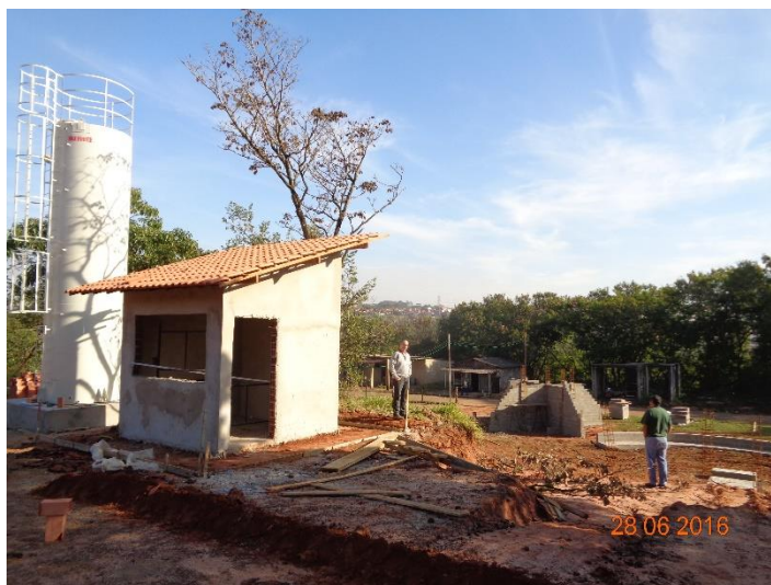
Figura 19: Usina de Reciclagem de RCC - Fase de Construção
