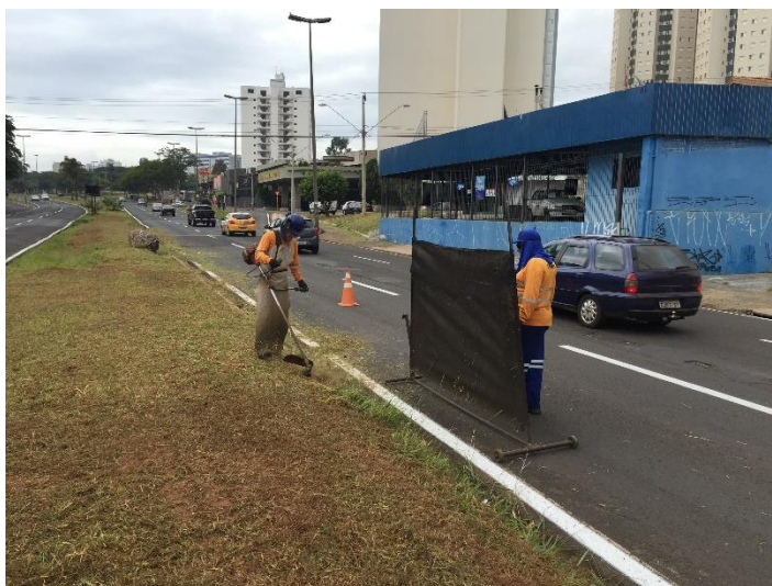
Figura 71: Capinação Sendo Executada pela EMDURB
