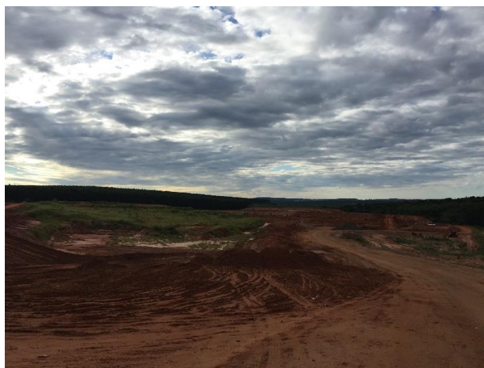
Figura 58: Vista geral do Aterro Sanitário
