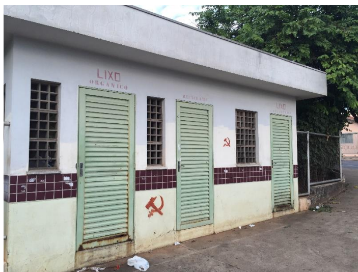
Figura 8: Acondicionamento Externo dos RSS – Pronto Socorro Central
