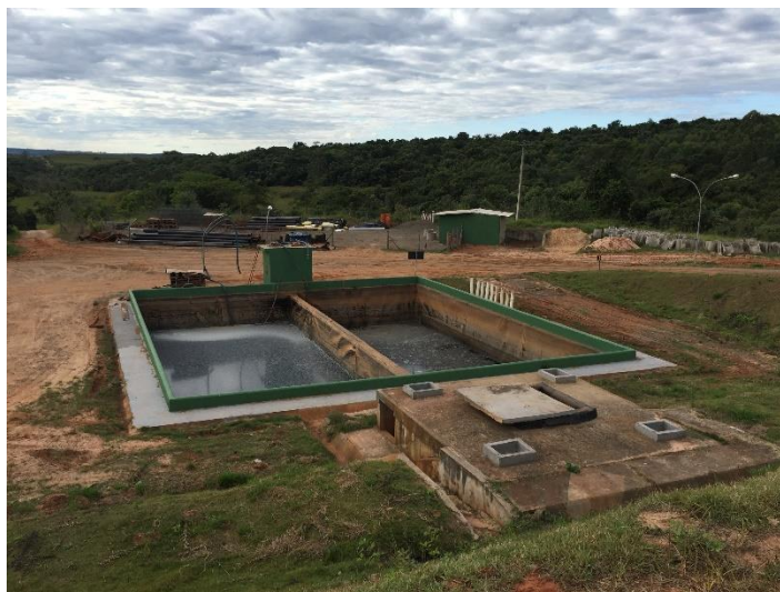
Figura 62: Tanque de Armazenamento de Chorume
