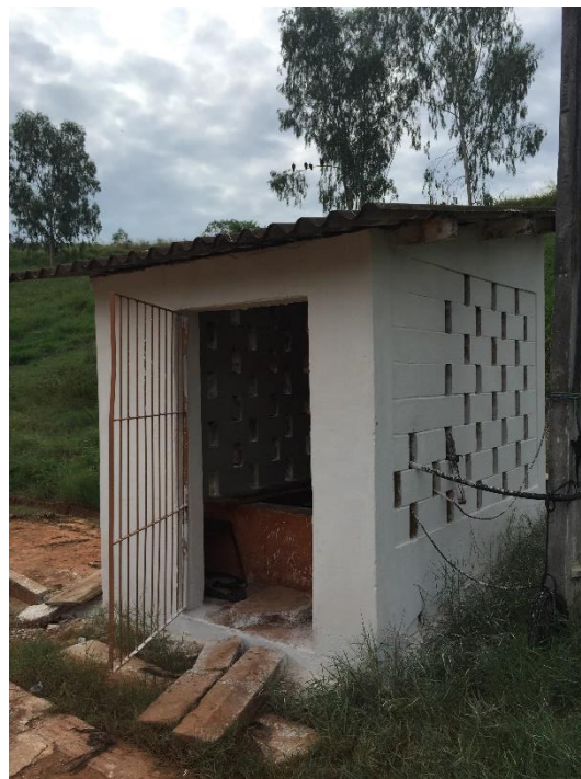
Figura 66: Poço de Recalque de Chorume
