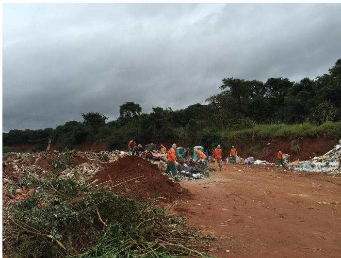
Figura 16: Triagem de RCC
