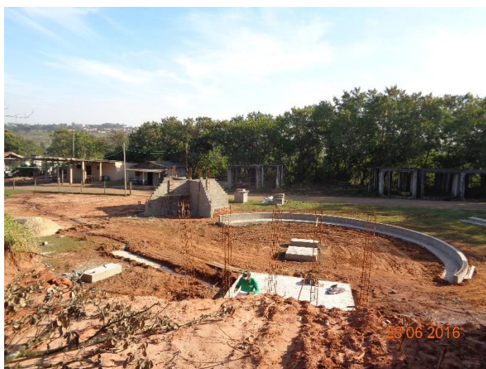
Figura 18: Usina de Reciclagem de RCC - Fase de Construção
