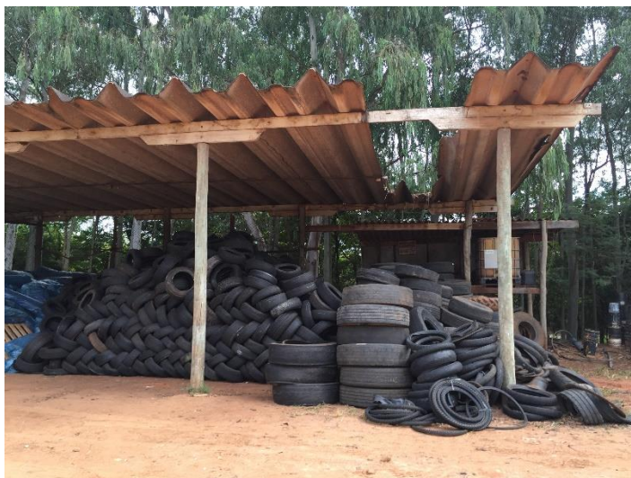
Figura 26: Telhado Danificado na Estrutura
